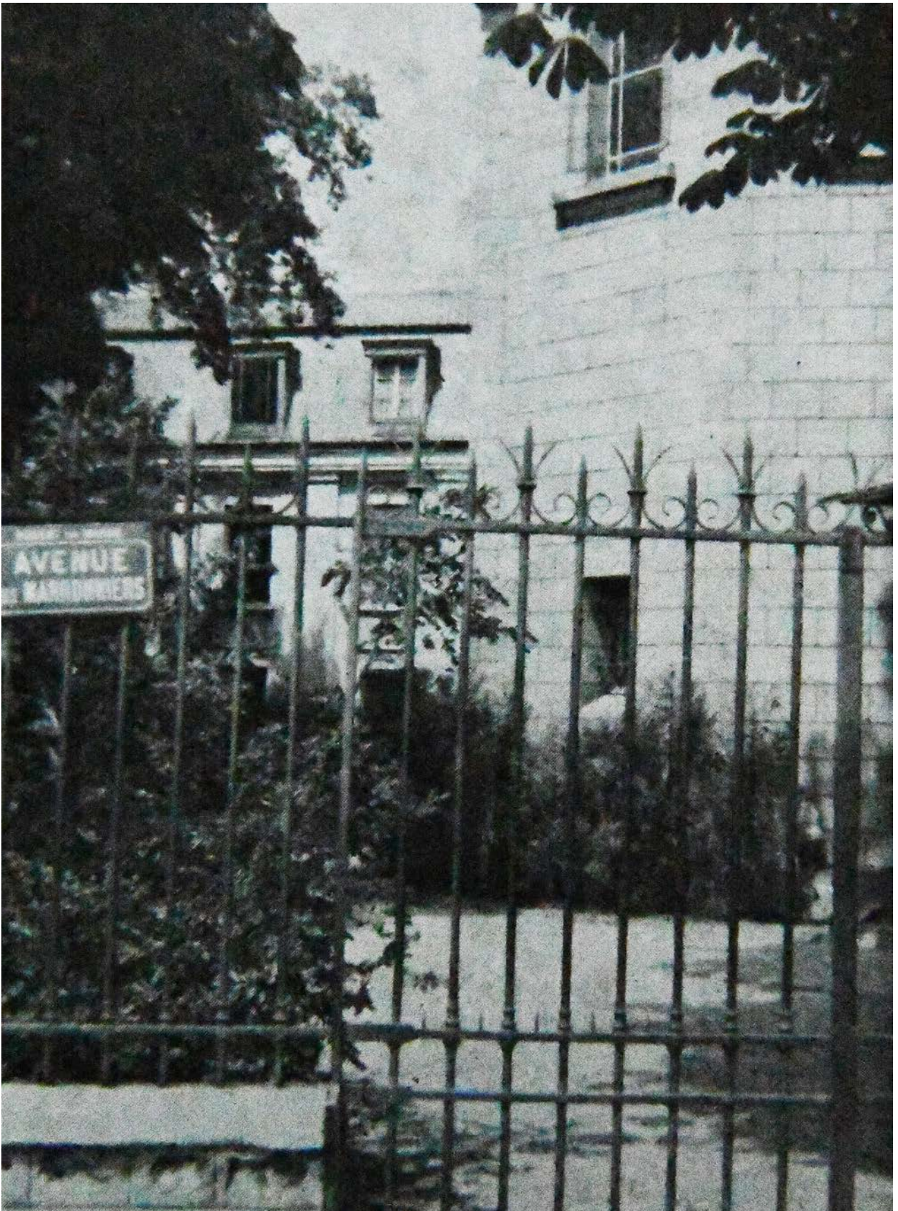
Entrée ancien bâtiment - 1970
